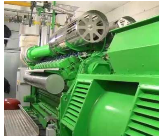
Cogénération de Ploubazlanec (22)
