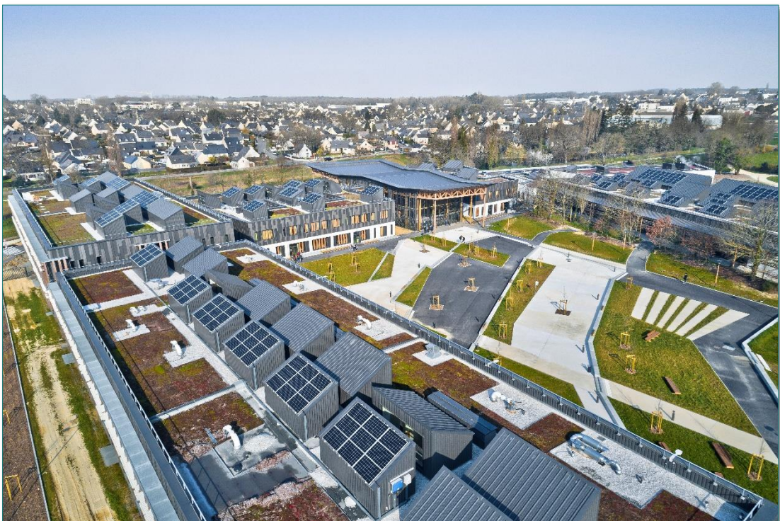
Construction du Lycée Simone Veil à Liffré (35) : vue sur les toits végétalisés et les panneaux photovoltaïques © Jérôme Sevrette
