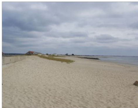
Avant installation des AlgoBox® (septembre 2018)
